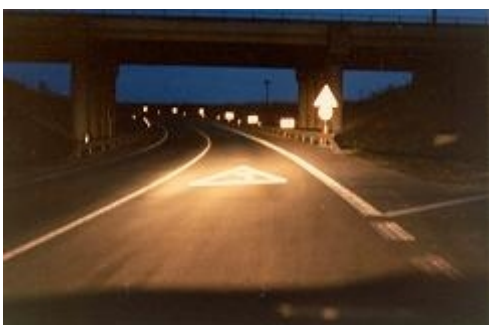
Obr. 2: Dřívě nehodová zatáčka na okraji Písku (noc)
