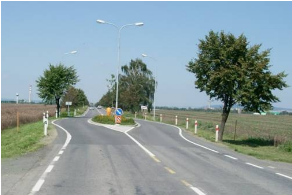
Obrázek 3: Definitivní řešení vjezdovým ostrůvkem (8/2006)
