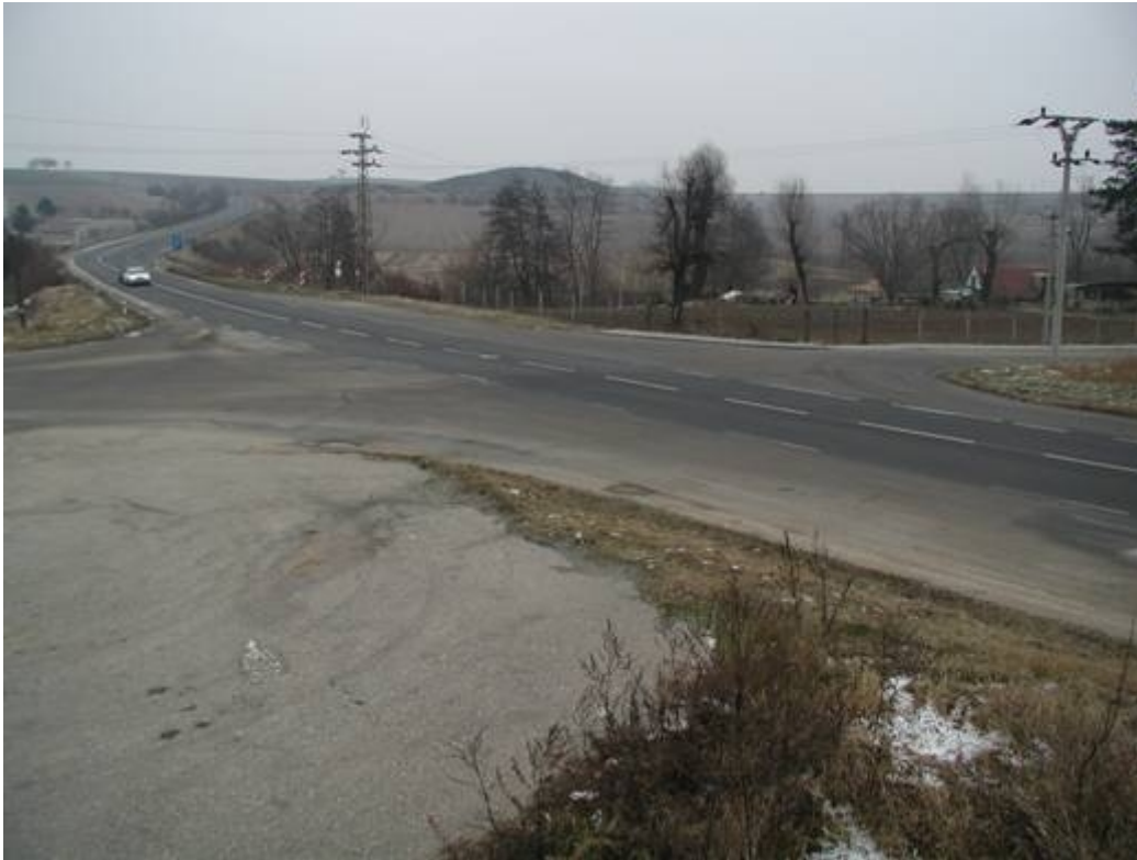
Obr 2: Pohled na křižovatku před úpravou (foto 12/2002, směr Vyškov)
