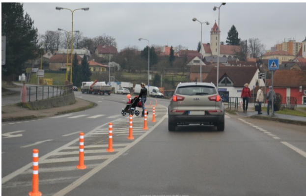
Obrázek 06. Flexibilní regulační sloupky - oranžové
