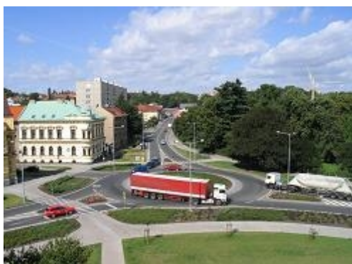
Obr. 23: Styková křižovatka nahrazená okružní (I/37, Chrudim)
