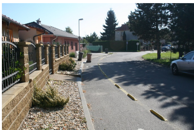
Obrázek 10. Břeclav – před osazením
