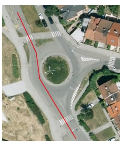
obr. 03. Nevhodně navržená OK - možný přímý průjezd
