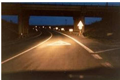
Obr. 2: Dřívě nehodová zatáčka na okraji Písku (noc)
