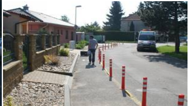
Obrázek 11. Břeclav – krátce po osazení
