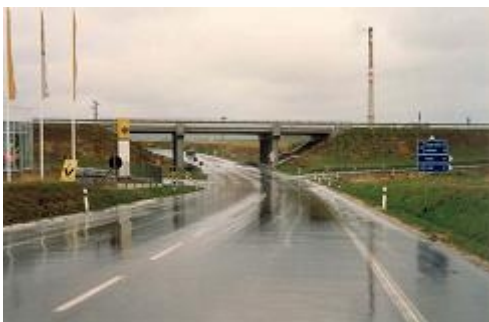
Obr. 1: Dříve nehodová zatáčka na okraji Písku (den)
