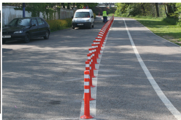
Obrázek 15. Benešov - po osazení (květen 2014)
