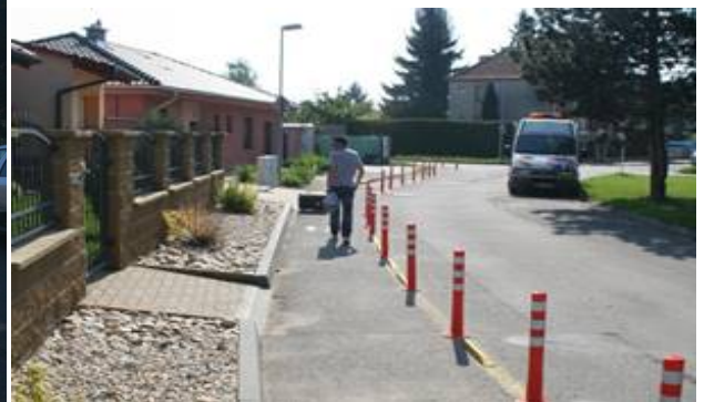
Obrázek 11. Břeclav – krátce po osazení
