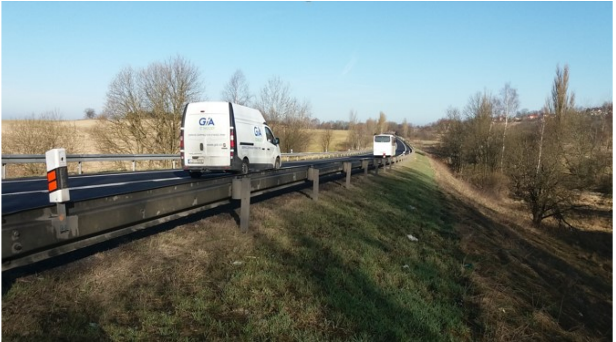
Svodidlové silniční směrové sloupky (realizace ze silnice I. třídy Karlovy Vary - Praha)
