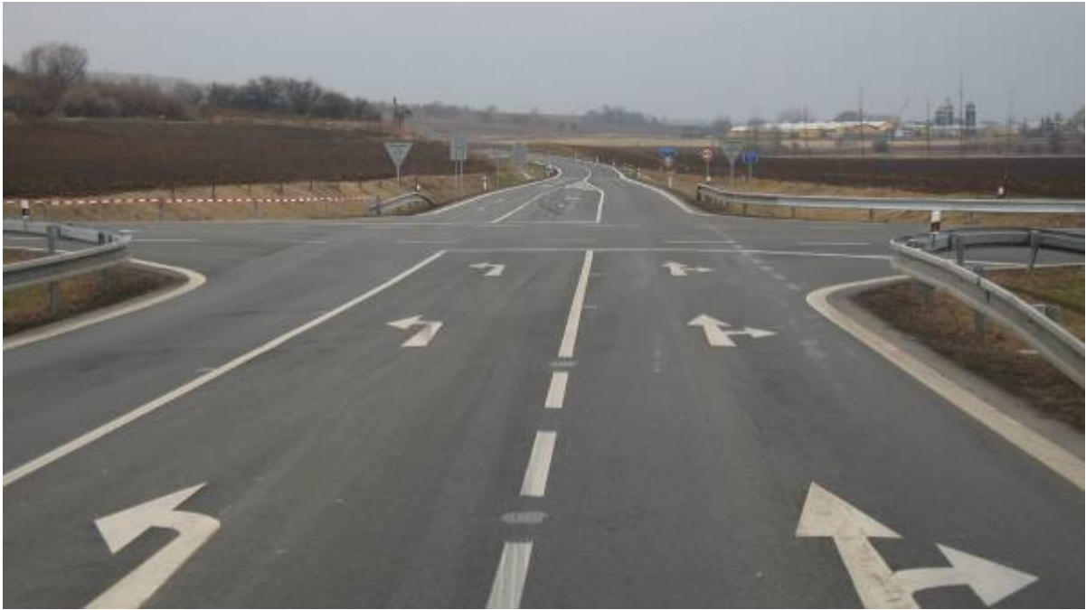
Obr. 1 Komfortní uspořádání vedlejší silnice nepodporuje povinnost dát přednost v jízdě
