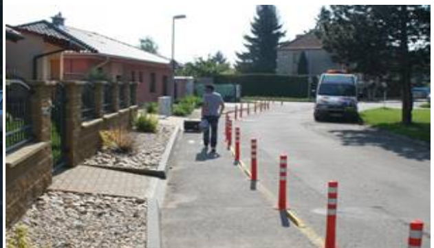
Obrázek 11. Břeclav – krátce po osazení
