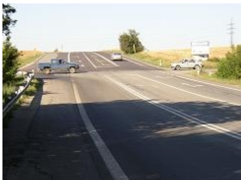
Obr. 22: Rozlehlá a nebezpečná kolizní plocha (II/430, Vyškov-Brno)
