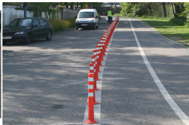
Obrázek 15. Benešov - po osazení (květen 2014)
