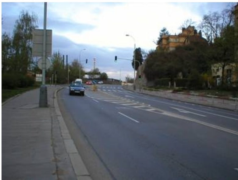
Obr. Pohled na zúžený čtyřpruh v místě přechodu
