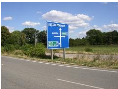
Obr. 5: Agresivní podpěrné konstrukce profilu I (SRN)
