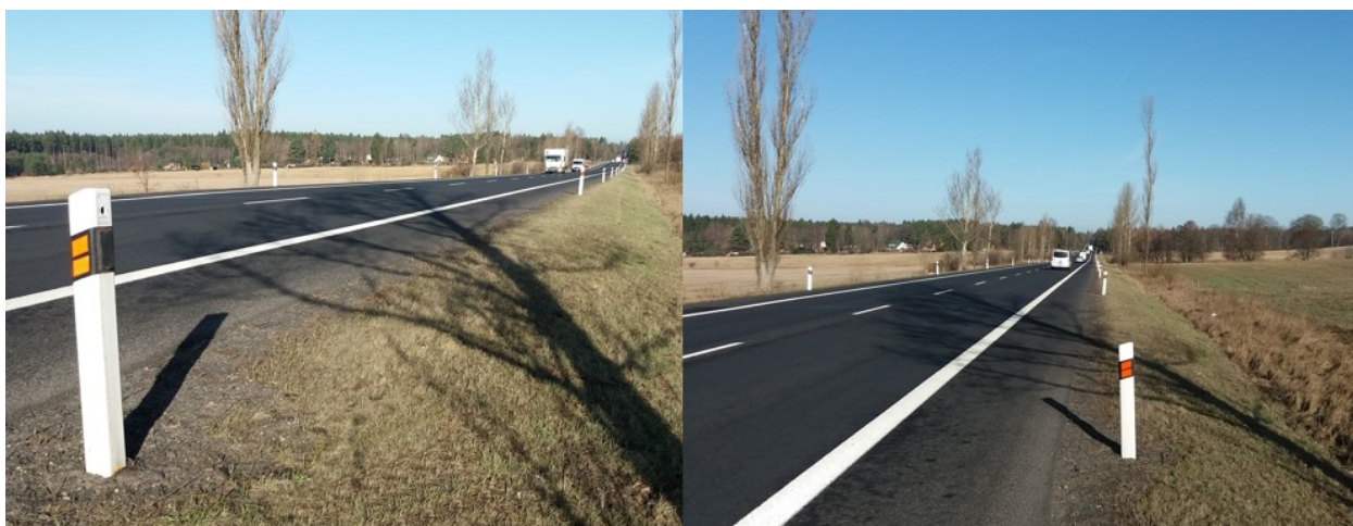
Plastové silniční směrové sloupky (realizace ze silnice I. třídy Karlovy Vary - Praha)
