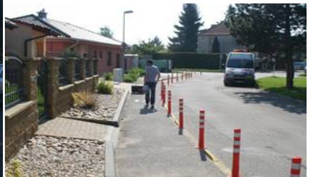
Obrázek 11. Břeclav – krátce po osazení
