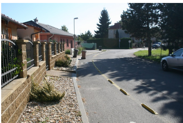
Obrázek 10. Břeclav – před osazením
