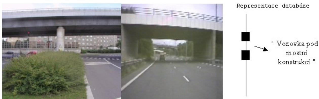
Obr. 3: Reálná situace případu Vozovka pod silniční konstrukcí, Praha 9
