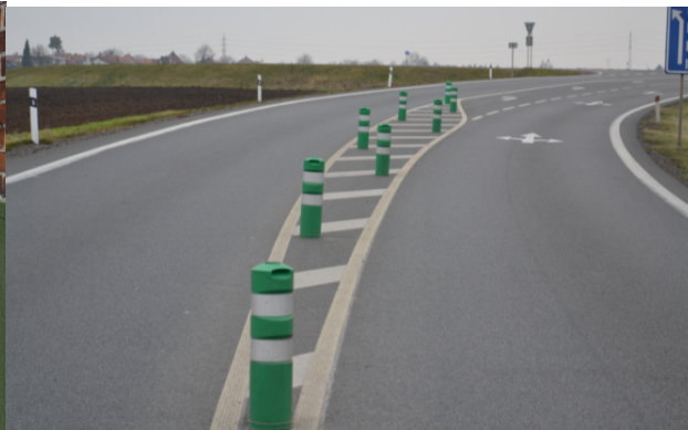
Obrázek 09. Směrové sloupky zelené kulaté - baliseta
