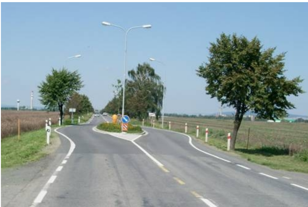
Obrázek 3: Definitivní řešení vjezdovým ostrůvkem (8/2006)
