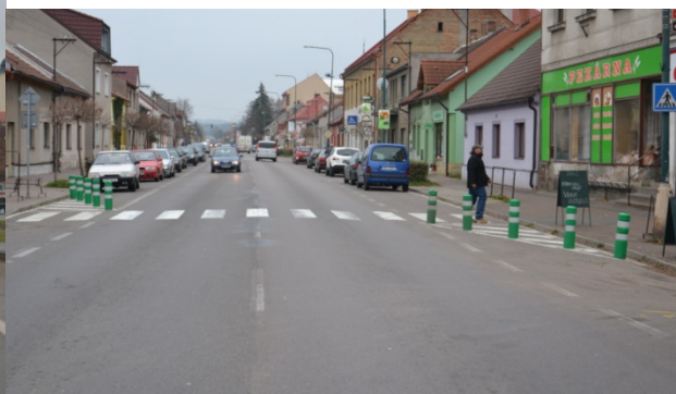
Obrázek 07. Směrové sloupky zelené kulaté - baliseta
