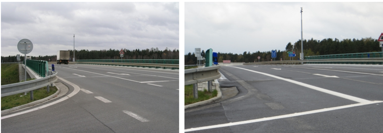
Obr. 3 Výhled řidiče na sledované lokalitě před a po úpravě VDZ (zdroj: CDV a ŘSD)
