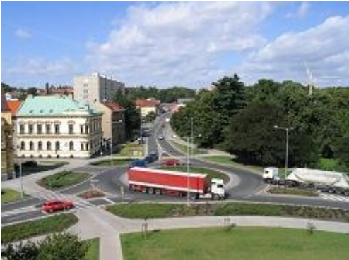
Obr. 23: Styková křižovatka nahrazená okružní (I/37, Chrudim)
