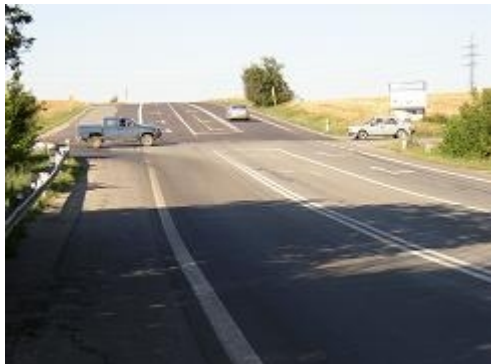
Obr. 22: Rozlehlá a nebezpečná kolizní plocha (II/430, Vyškov-Brno)
