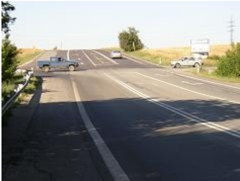
Obr. 22: Rozlehlá a nebezpečná kolizní plocha (II/430, Vyškov-Brno)
