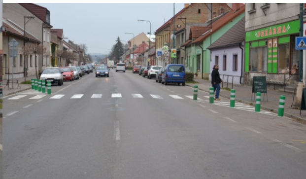
Obrázek 07. Směrové sloupky zelené kulaté - baliseta
