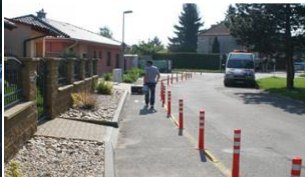
Obrázek 11. Břeclav – krátce po osazení
