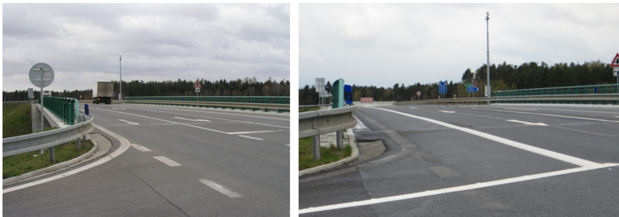
Obr. 3 Výhled řidiče na sledované lokalitě před a po úpravě VDZ (zdroj: CDV a ŘSD)
