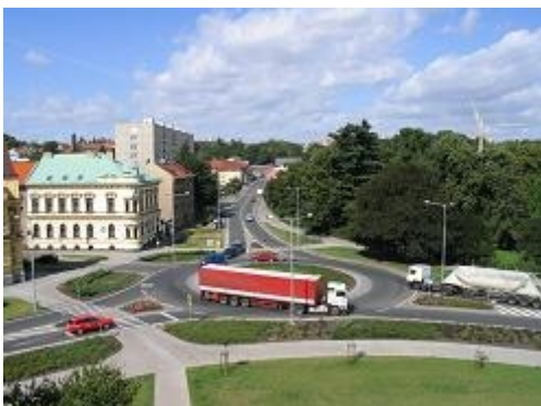
Obr. 23: Styková křižovatka nahrazená okružní (I/37, Chrudim)
