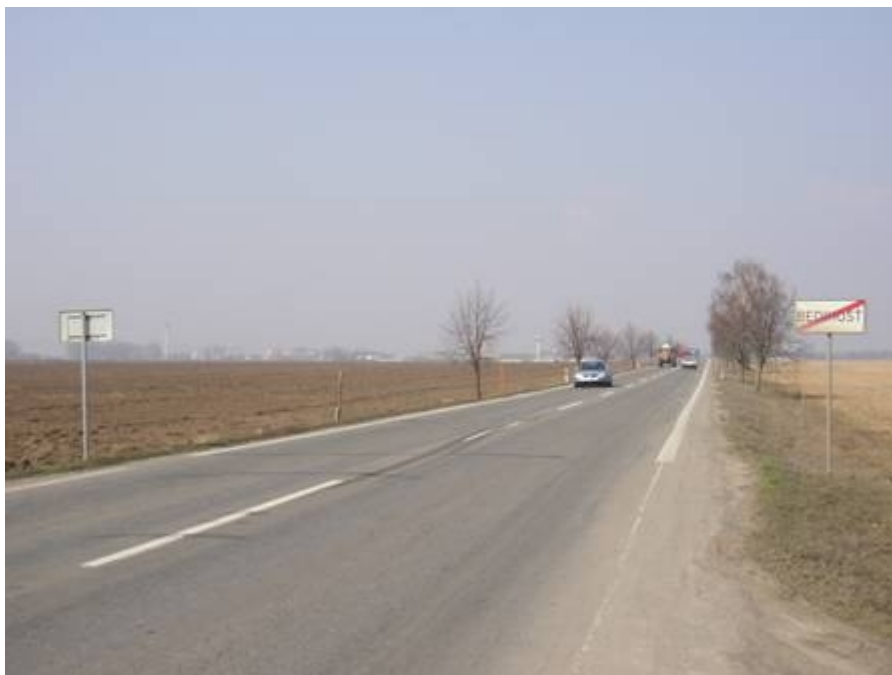
Obrázek 1: Vjezd do Bedihošti od Prostějova – místo současného vjezdového ostrůvku (3/2003)
