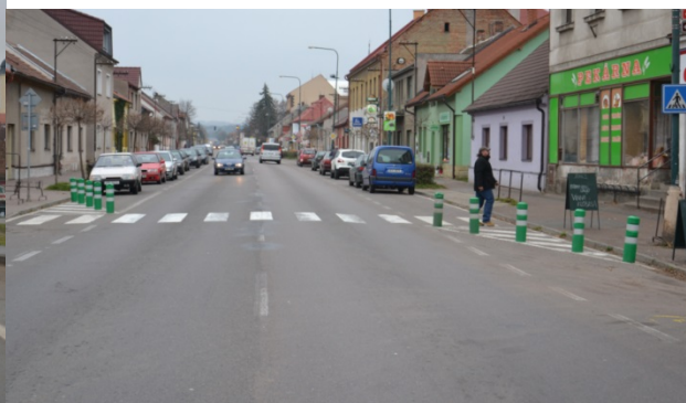
Obrázek 07. Směrové sloupky zelené kulaté - baliseta
