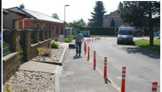
Obrázek 11. Břeclav – krátce po osazení
