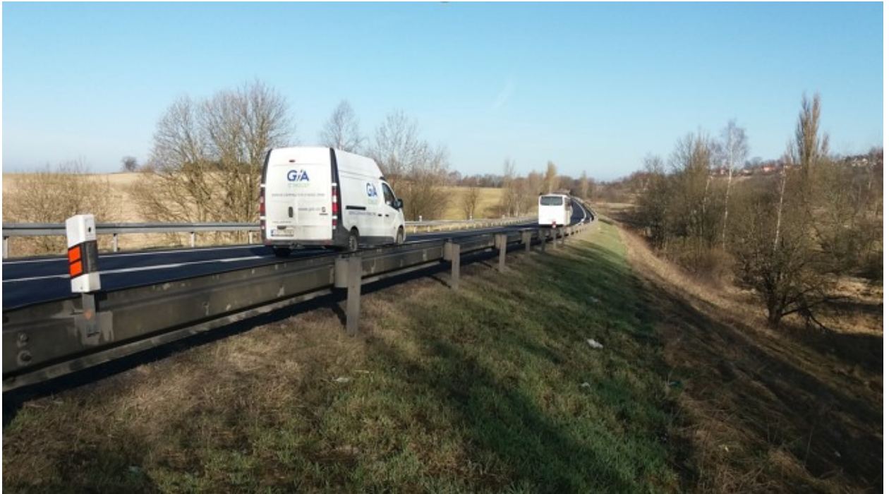
Svodidlové silniční směrové sloupky (realizace ze silnice I. třídy Karlovy Vary - Praha)
