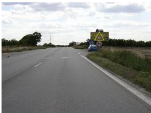
Obr. 4: Špatný kontrast značky na nevhodném pozadí (Brno-Přízřenice)
