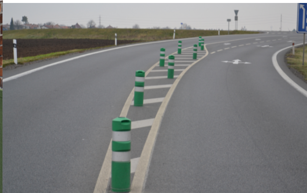
Obrázek 09. Směrové sloupky zelené kulaté - baliseta
