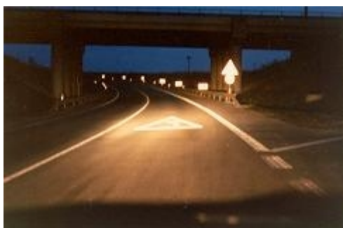
Obr. 2: Dřívě nehodová zatáčka na okraji Písku (noc)
