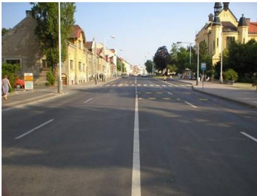
Obr: pohled na přechod s BUS zastávkou, chráněný úzkými zpomalovacími prahy
