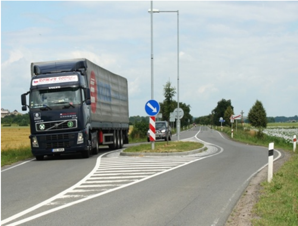
Obr. 2: Ochranný ostrůvek pro podporu přecházení – Prostějov.
