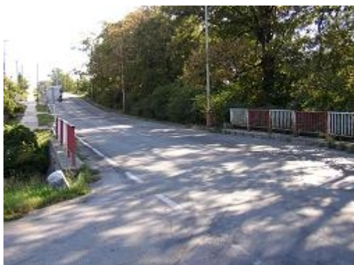
Obr. 18: Nákladní automobil zakrytý značkou (II/430, Rousínov)
