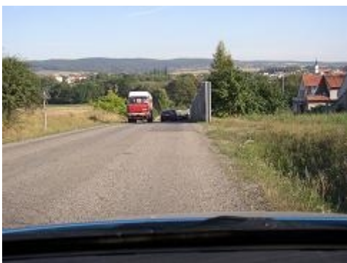
Obr. 8: Nebezpečný okraj protihlukové zdi (přivaděč dálnice D 1, Rousínov)
