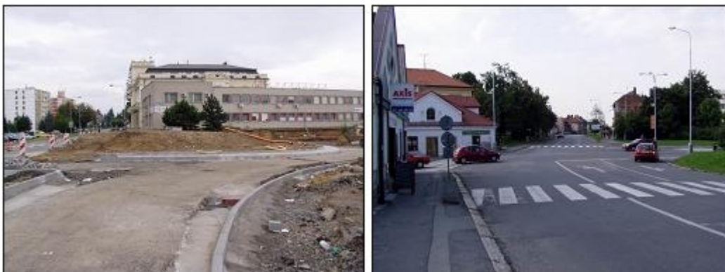
Obr.1 - Vybudovat okružní nebo světelně řízenou křižovatku? Anebo ponechat stávající stav? (Hranice a Čáslav, 2005 - foto autor)
