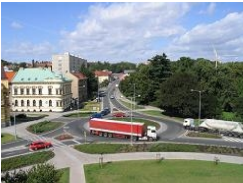
Obr. 23: Styková křižovatka nahrazená okružní (I/37, Chrudim)
