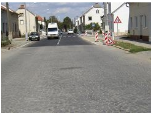
Obr. 11: Chybějící připojovací pruh (D 1, Rohlenka)
