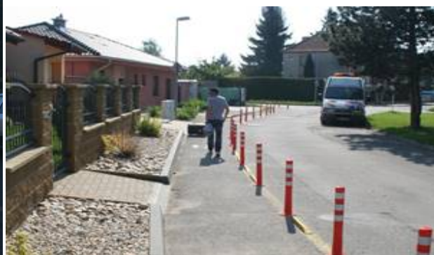
Obrázek 11. Břeclav – krátce po osazení
