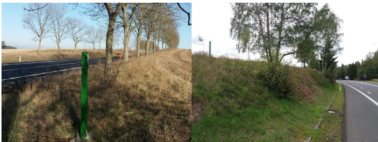
Kovové silniční směrové sloupky (realizace ze silnice I. třídy Karlovy Vary - Praha)
